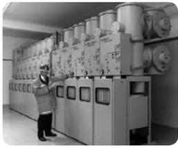
Tablero aislado al 100% en gas SF<sub>6</sub> modelo WI
