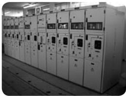
Tablero aislado en gas SF<sub>6</sub> modelo CBGS0
