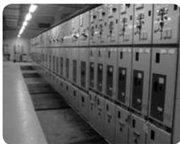
Tablero aislado en aire modelo PIX, 17.5-24 kV
